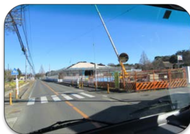
（建設中の歴史文化交流館）
